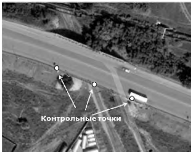
Рис. 5. Расположение контрольных точек на Майкудукском мосту
