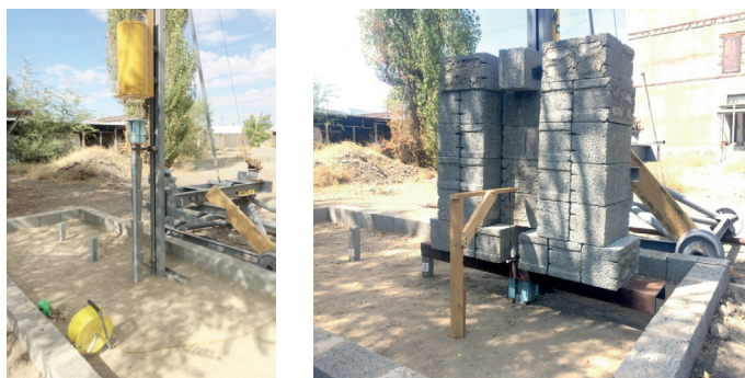
Рисунок 2 – Фрагменты забивки и испытания свай на полигоне
