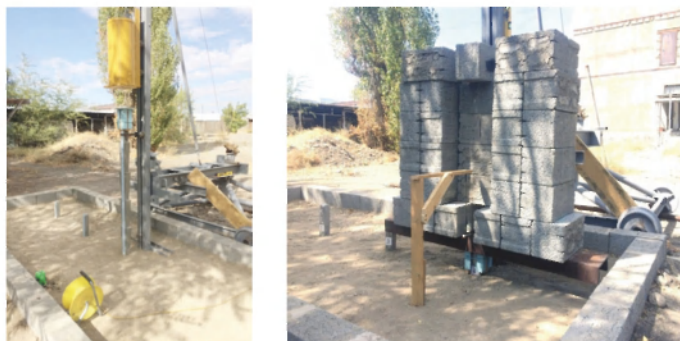
Рисунок 2 – Фрагменты забивки и испытания свай на полигоне
